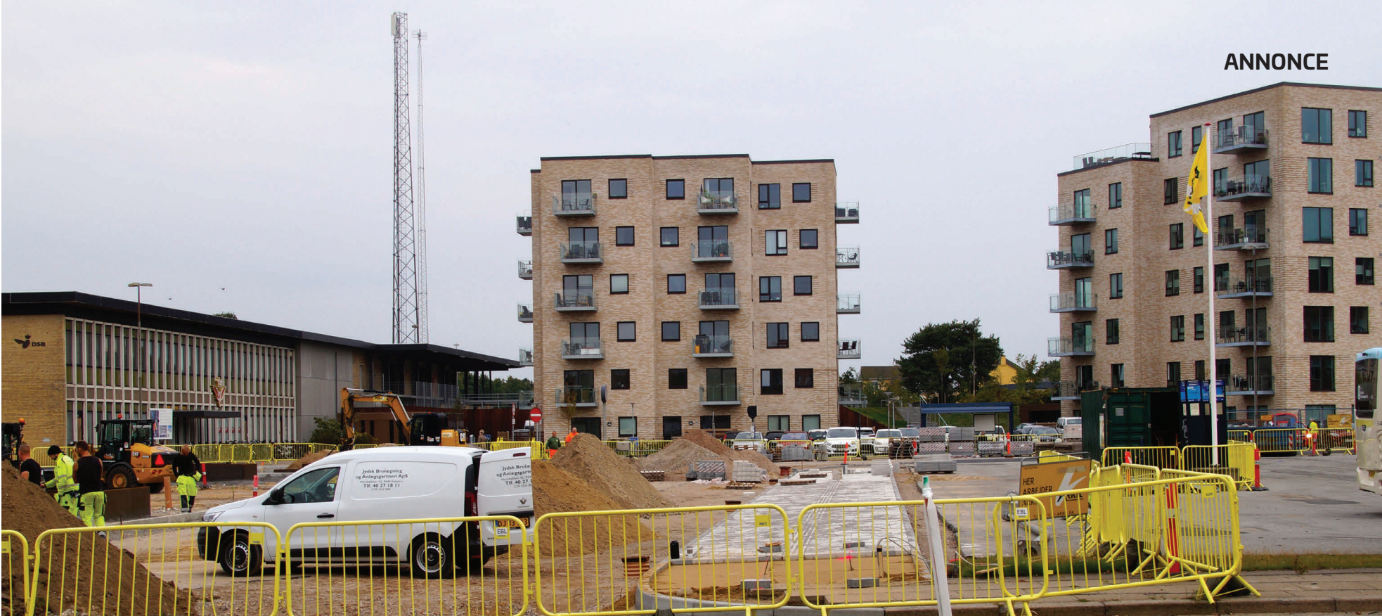
Banegårdspladsen i Brønderslev er under kraftig forvandling.
